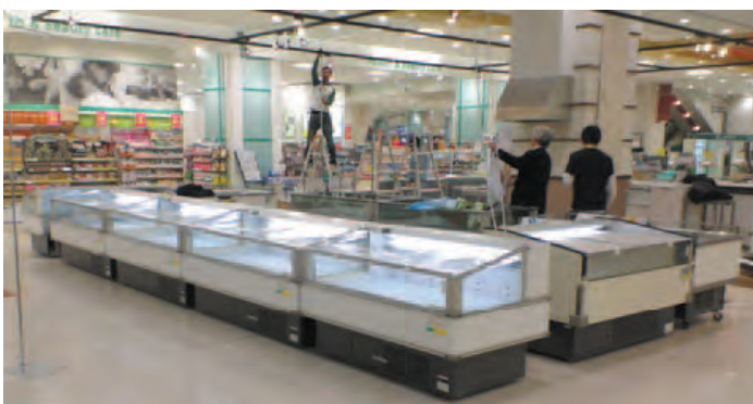
現場施工風景
